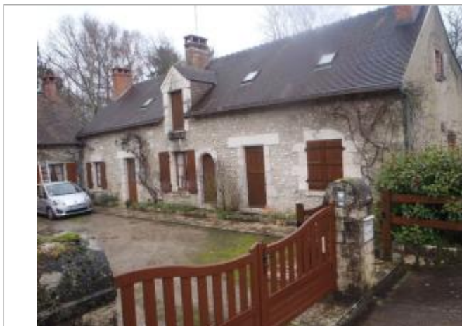
Vue du site (source : CEREMA, 2018)
