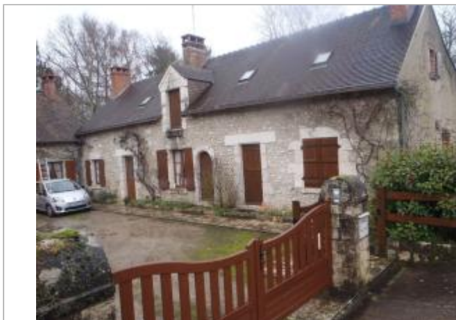
Vue du site (source : CEREMA, 2018)
