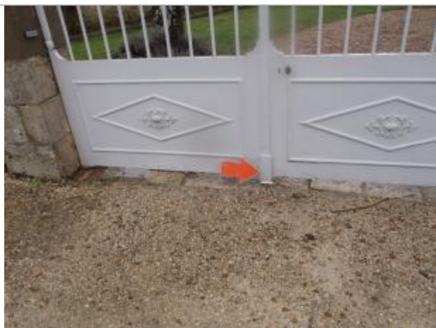
Vue du repère (source : CEREMA, 2018)
