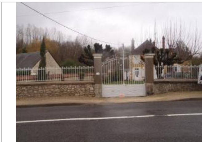
Vue du site (source : CEREMA, 2018)
