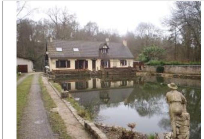
Vue du site (source : CEREMA, 2018)
