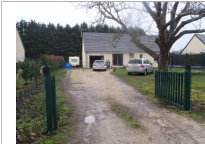
Vue du site (source : CEREMA, 2018)
