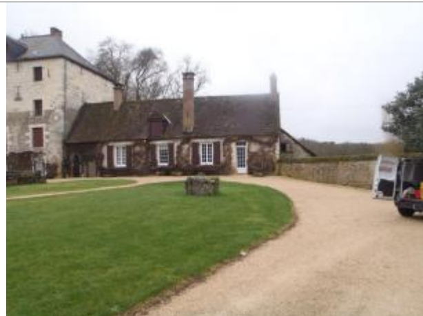
Vue du site (source : CEREMA, 2018)
