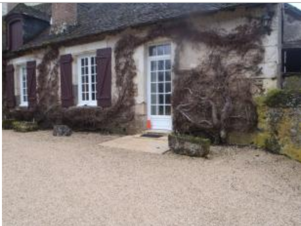
Vue du repère (source : CEREMA, 2018)
