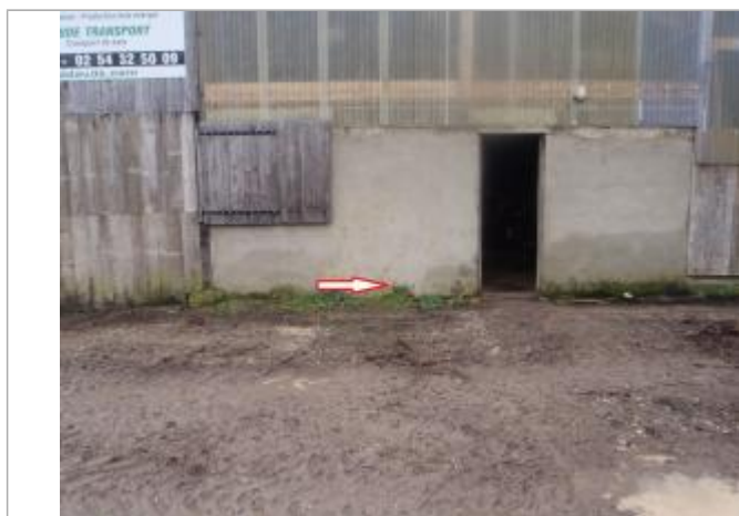
Vue du repère (source : CEREMA, 2018)
