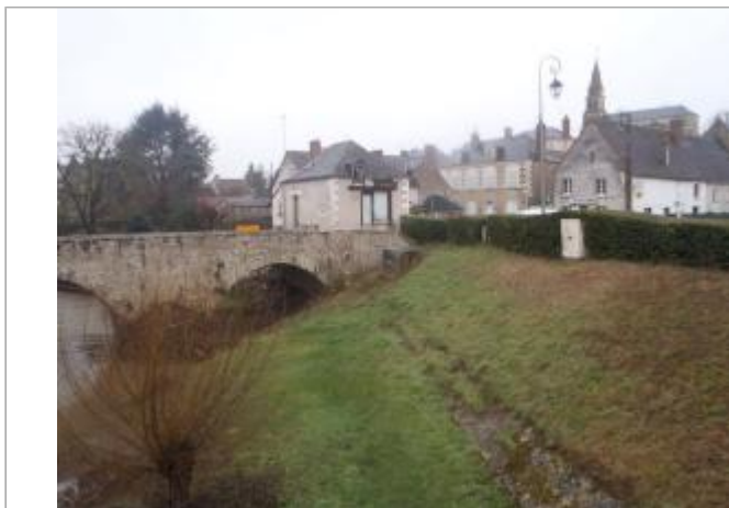
Vue du site (source : CEREMA, 2018)
