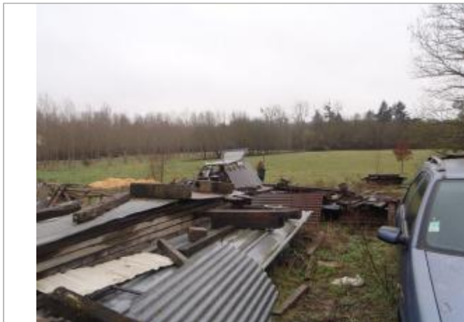
Vue du site (source : CEREMA, 2018)
