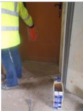
Vue du repère (source : CEREMA, 2018)
