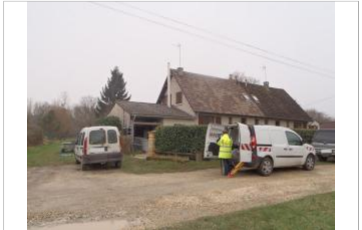
Vue du site (source : CEREMA, 2018)
