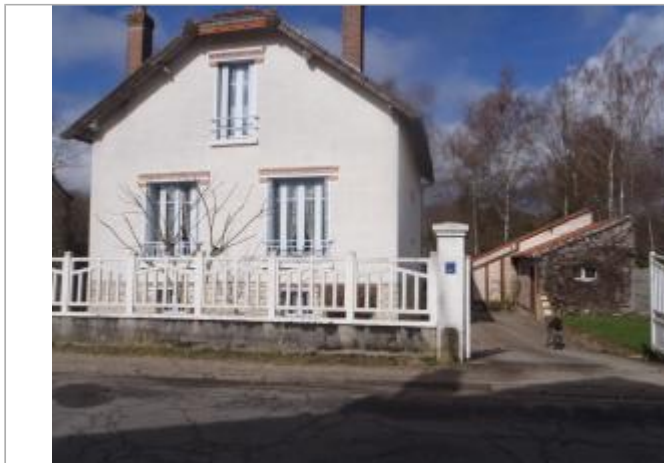
Vue du site (source : CEREMA, 2018)
