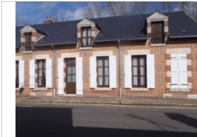
Vue du site (source : CEREMA, 2018)
