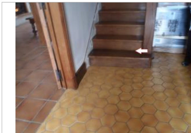
Vue du repère (source : CEREMA, 2018)
