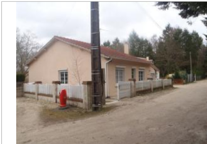
Vue du site (source : CEREMA, 2018)
