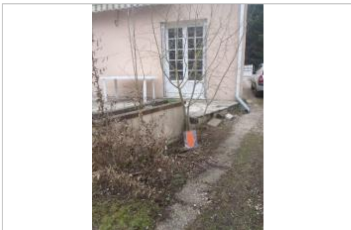
Vue du repère (source : CEREMA, 2018)
