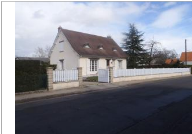
Vue du site (source : CEREMA, 2018)
