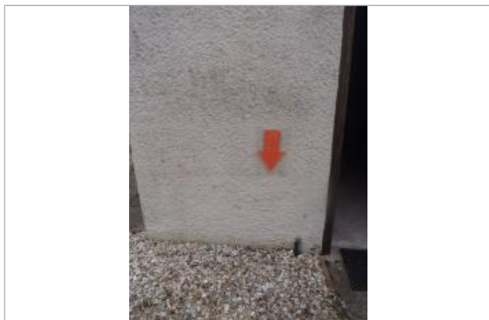
Vue du repère (source : CEREMA, 2018)
