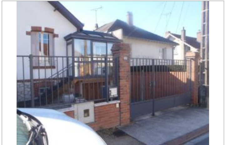
Vue du site (source : CEREMA, 2018)
