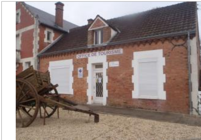
Vue du site (source : CEREMA, 2018)
