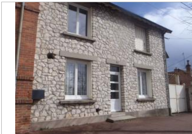
Vue du site (source : CEREMA, 2018)
