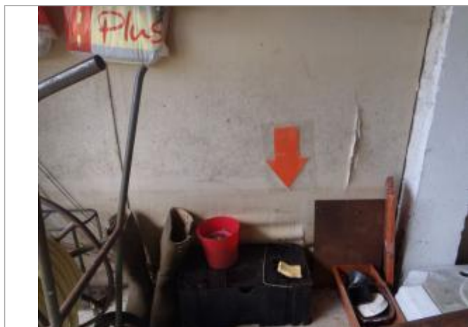
Vue du repère (source : CEREMA, 2018)
