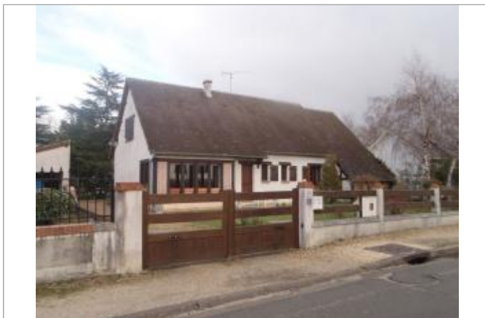
Vue du site (source : CEREMA, 2018)
