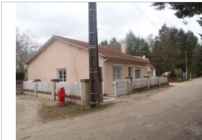
Vue du site (source : CEREMA, 2018)
