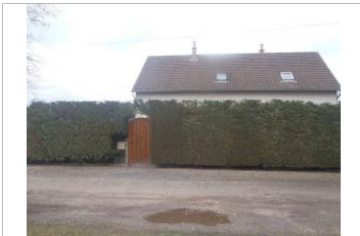
Vue du site (source : CEREMA, 2018)
