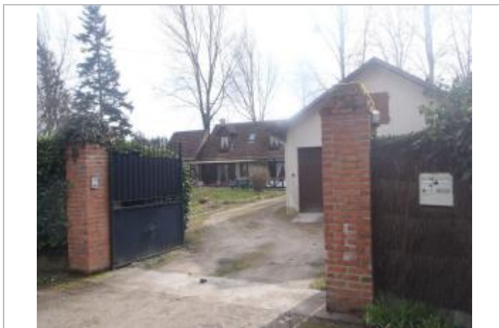
Vue du site (source : CEREMA, 2018)
