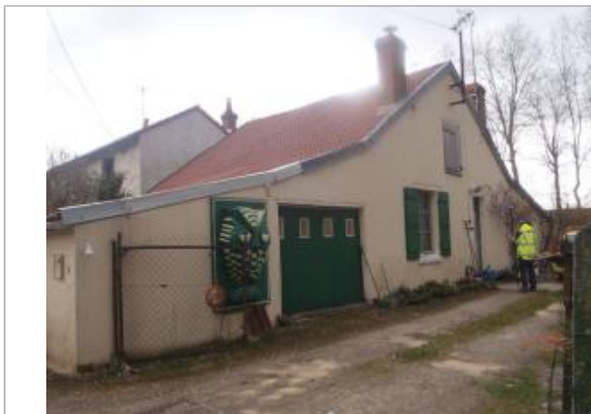
Vue du site (source : CEREMA, 2018)
