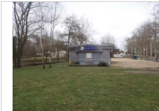
Vue du site (source : CEREMA, 2018)
