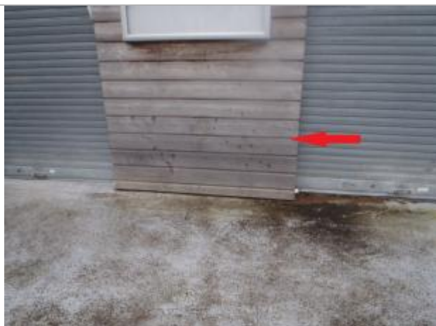
Vue du repère (source : CEREMA, 2018)
