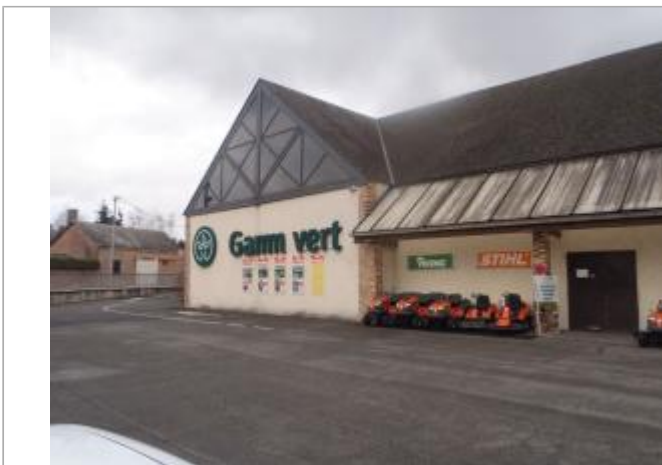
Vue du site (source : CEREMA, 2018)
