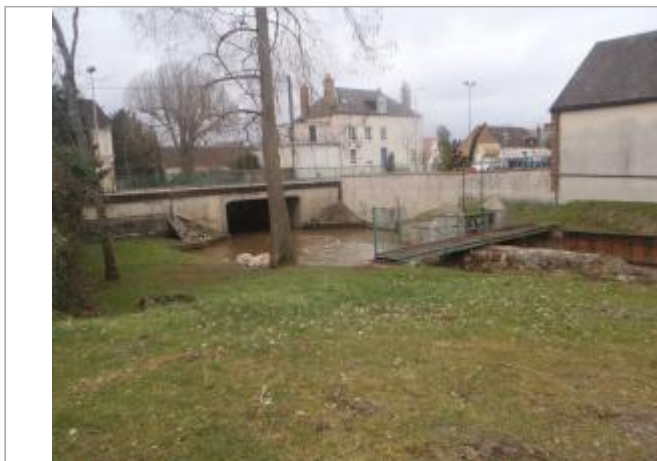
Vue du site (source : CEREMA, 2018)
