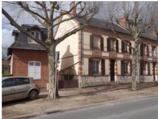
Vue du site (source : CEREMA, 2018)
