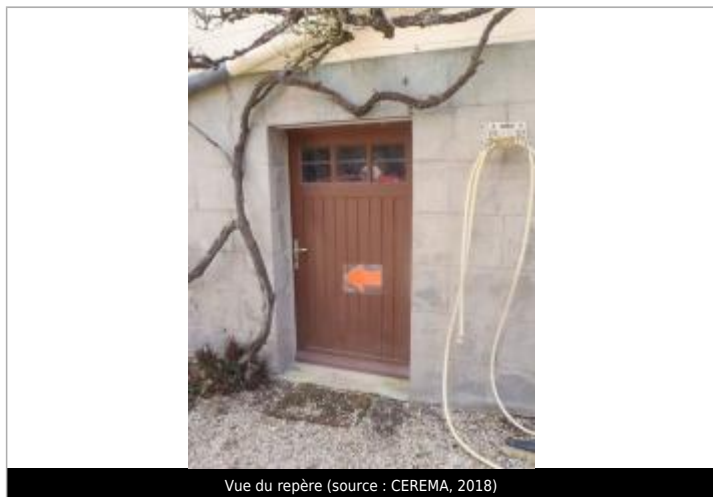
Vue du repère (source : CEREMA, 2018)
