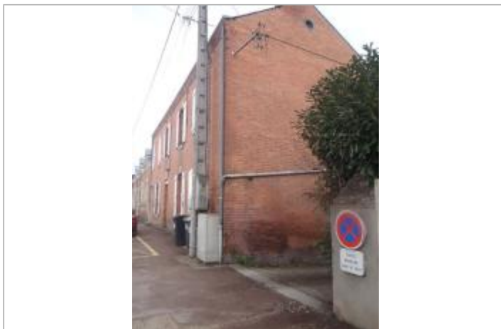
Vue du site (source : CEREMA, 2018)
