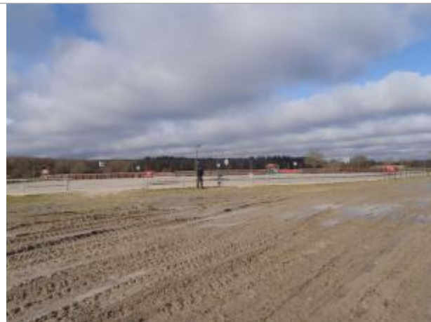
Vue du site (source : CEREMA, 2018)
