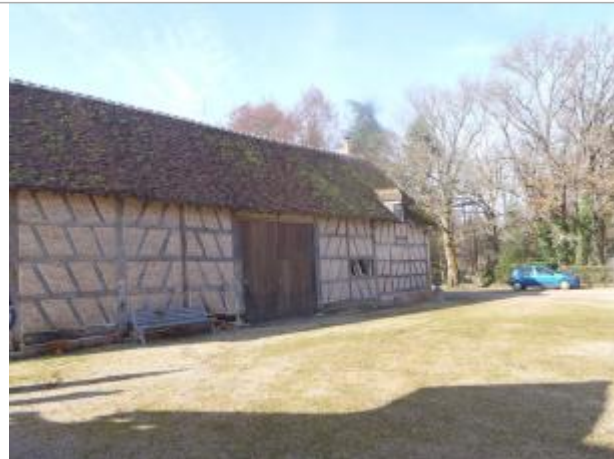
Vue du site (source : CEREMA, 2018)
