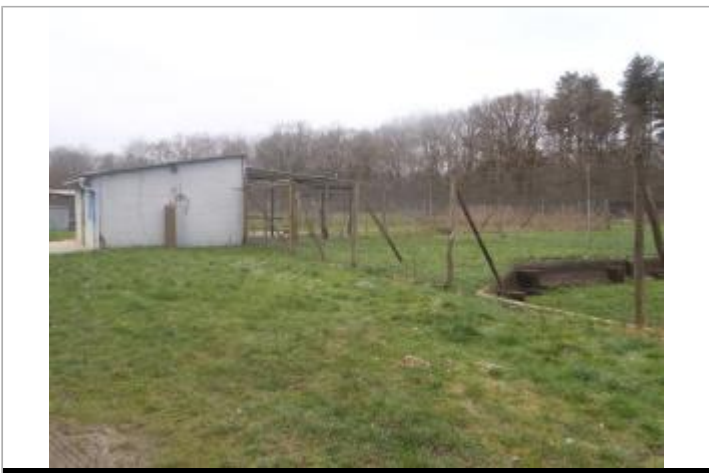
Vue du site (source : CEREMA, 2018)
