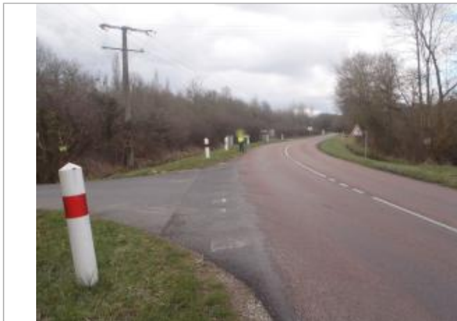
Vue du site (source : CEREMA, 2018)
