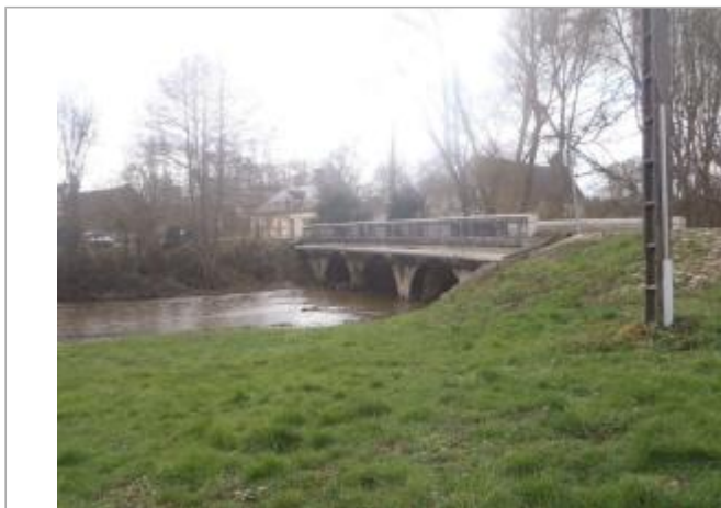
Vue du site (source : CEREMA, 2018)
