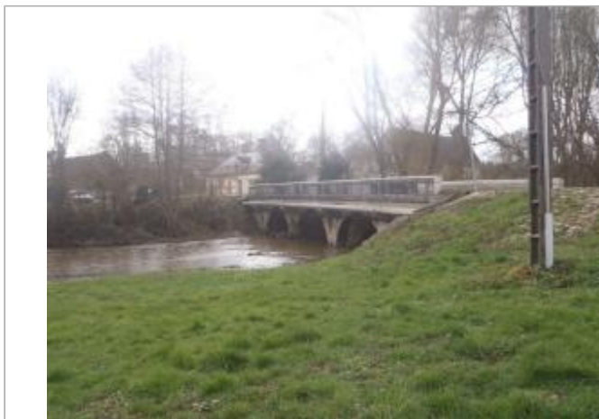
Vue du site (source : CEREMA, 2018)
