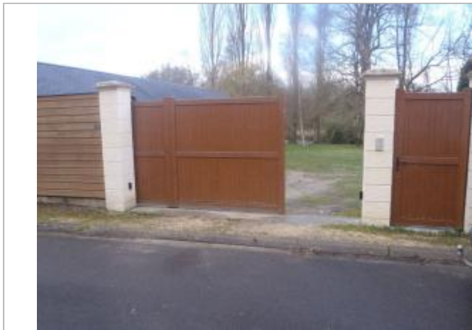
Vue du site (source : CEREMA, 2018)
