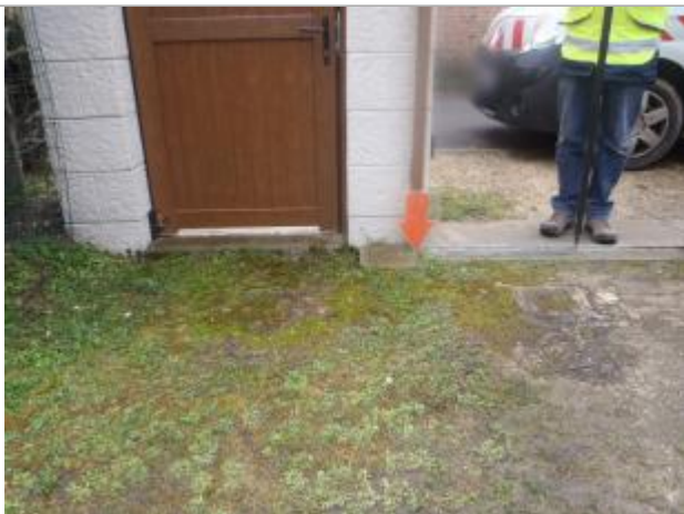
Vue du repère (source : CEREMA, 2018)
