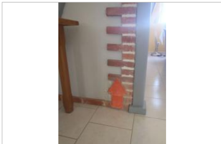
Vue du repère (source : CEREMA, 2018)
