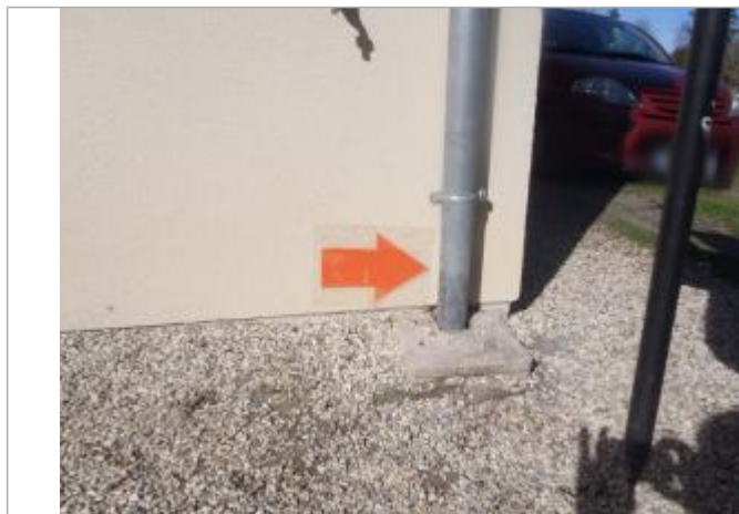
Vue du repère (source : CEREMA, 2018)
