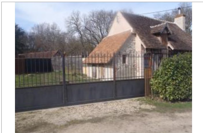
Vue du site (source : CEREMA, 2018)
