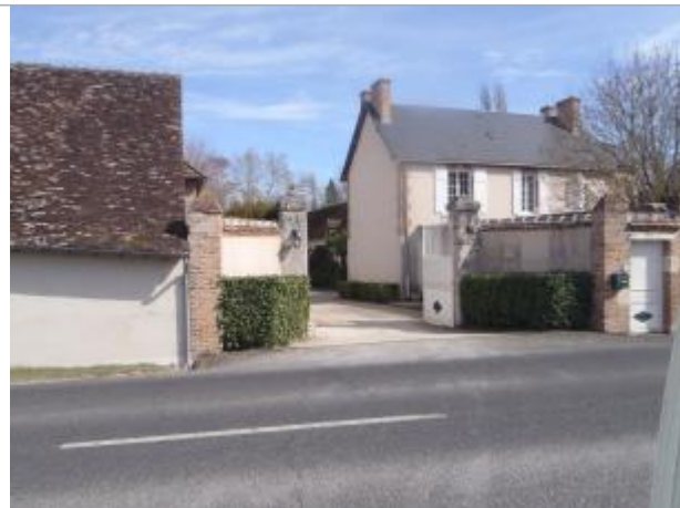
Vue du site (source : CEREMA, 2018)
