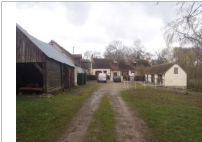
Vue du site (source : CEREMA, 2018)
