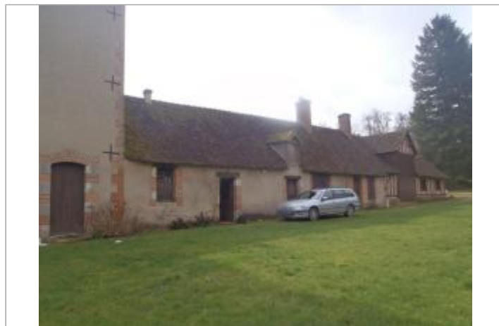
Vue du site (source : CEREMA, 2018)
