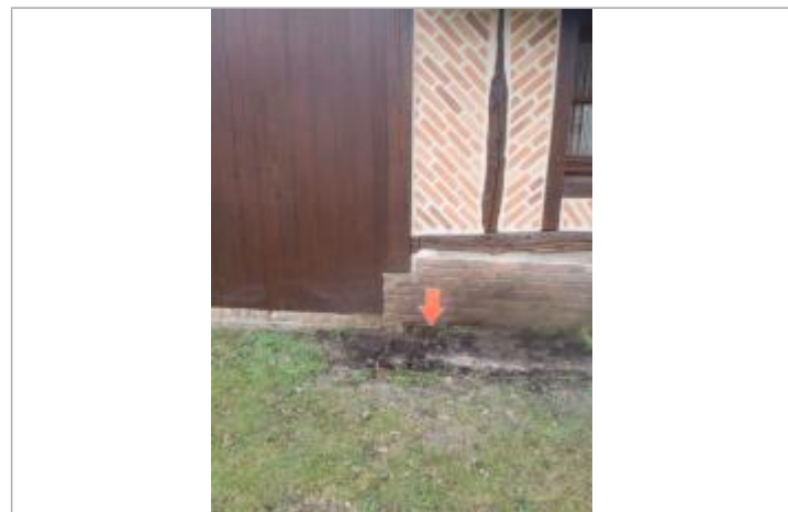
Vue du repère (source : CEREMA, 2018)
