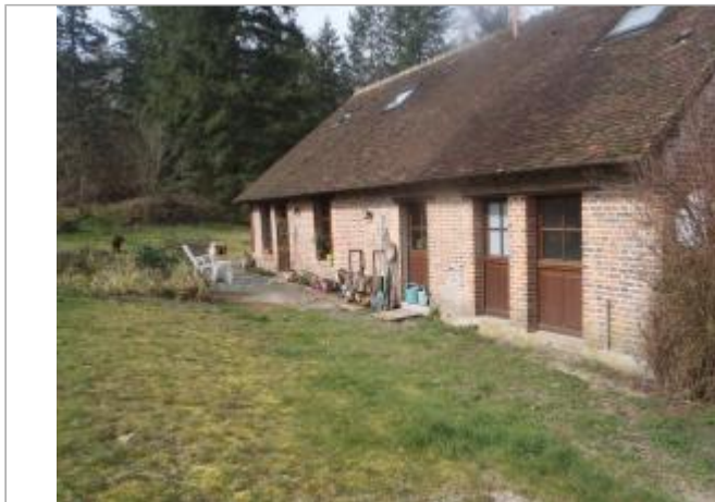
Vue du site (source : CEREMA, 2018)
