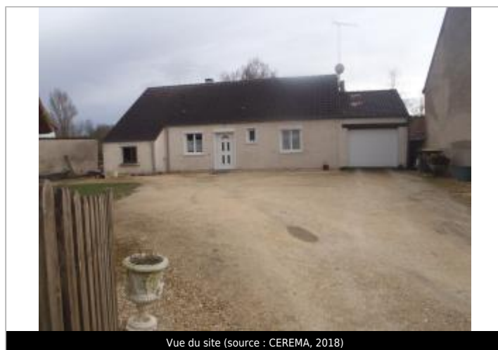
Vue du site (source : CEREMA, 2018)
