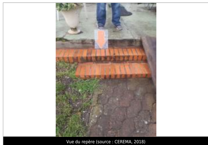
Vue du repère (source : CEREMA, 2018)
