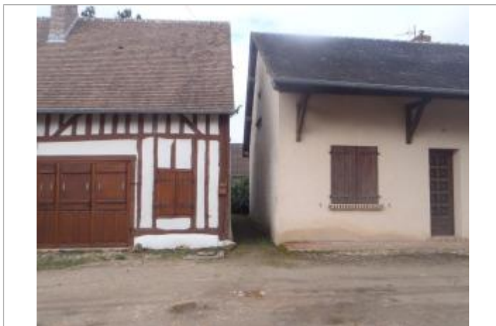
Vue du site (source : CEREMA, 2018)
