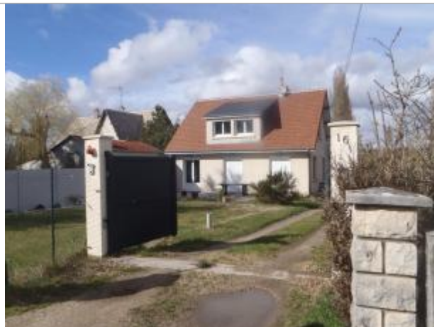
Vue du site (source : CEREMA, 2018)
