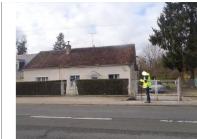
Vue du site (source : CEREMA, 2018)
