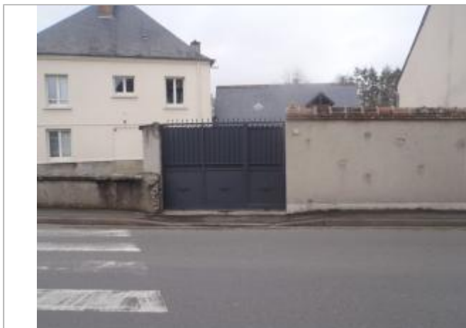
Vue du site (source : CEREMA, 2018)
