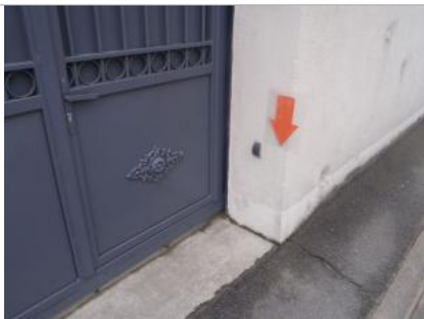
Vue du repère (source : CEREMA, 2018)
