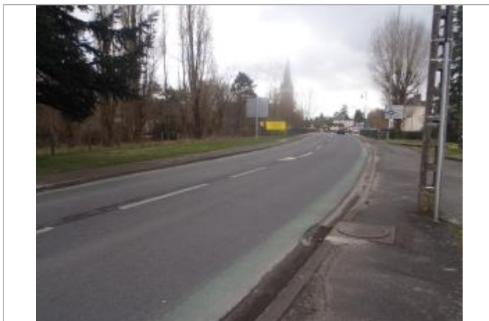
Vue du site (source : CEREMA, 2018)
