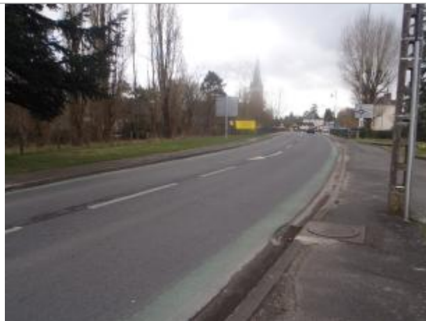
Vue du site (source : CEREMA, 2018)
