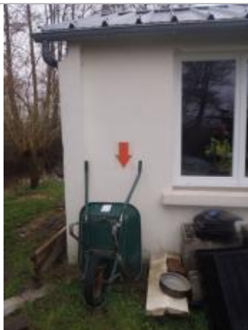
Vue du repère (source : CEREMA, 2018)
