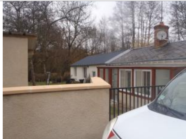
Vue du site (source : CEREMA, 2018)
