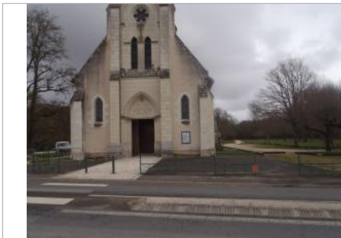
Vue du site (source : CEREMA, 2018)
